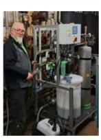
Durch die Anhebung des PH-Werts und der gleichzeitigen Filtration des Kreislaufwassers konnte wieder eine gleichbleibende Wasserqualität gemäß VdTÜV 1466 hergestelt werden.
