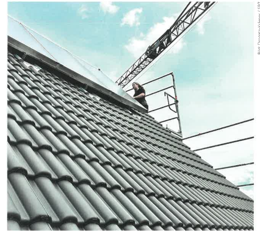
Jana Sonntag kontrolliert auf dem Dach eine neu installierte thermische Solaranlage.
